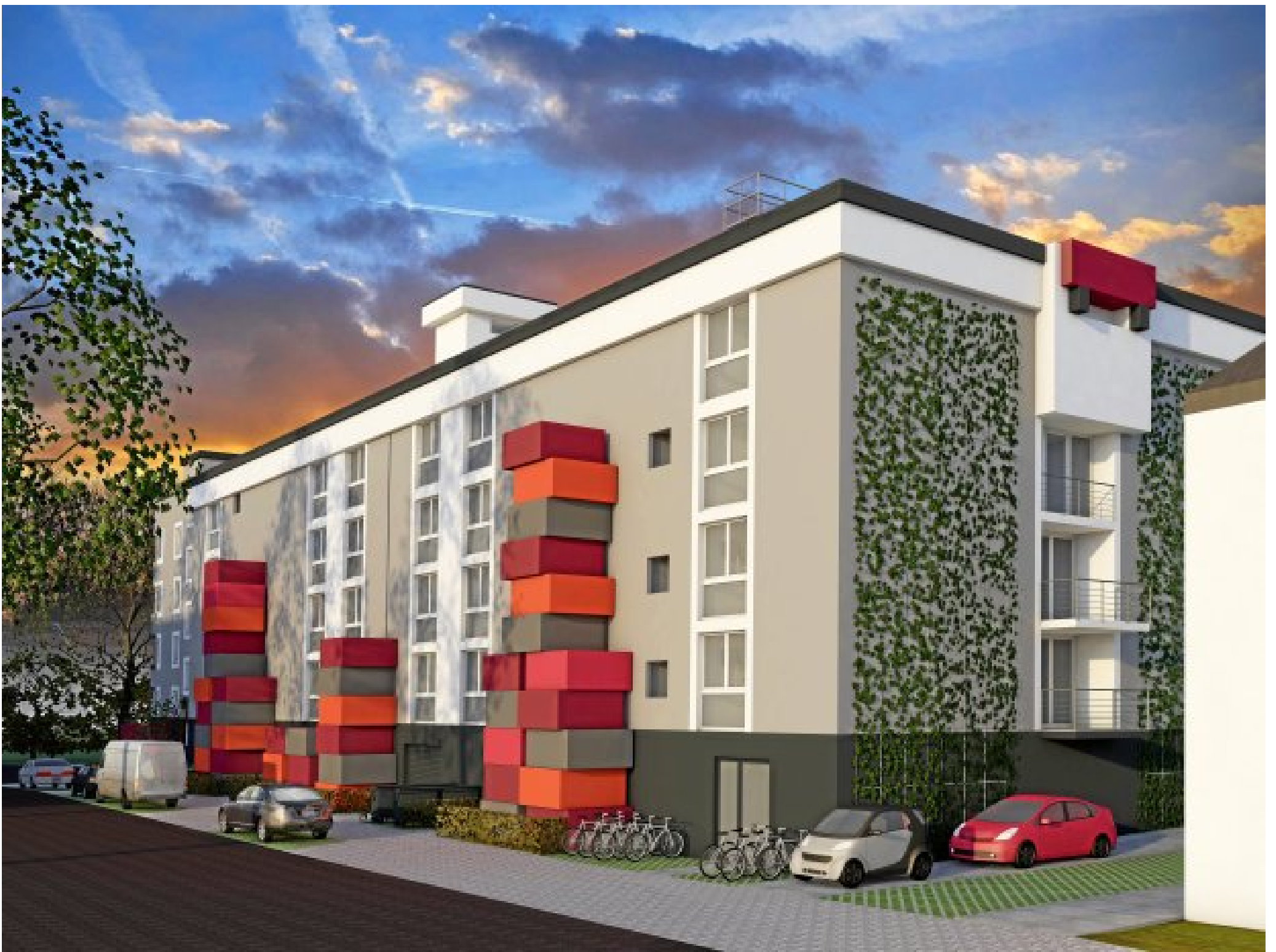
An der Nordseite des Gelsenkirchener Bunkers sollen die ausgeschnittenen Betonquader gestapelt und farblich akzentuiert werden. Foto: Lucas Braecklein / Iproton GmbH
