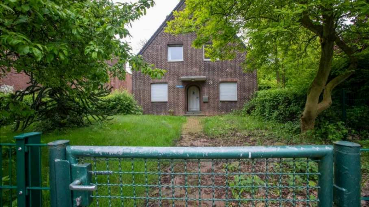
Das Pfarrhaus von St. Matthias wird energetisch saniert.
